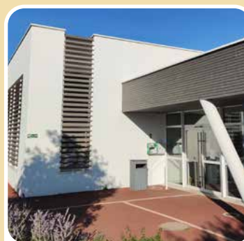
Salle des Pinsonnières : rue de Pinsonnières
